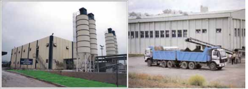
Şekil 3.4. Kireç siloları ve kireçle stabilize olmuş çamurun depolama sahasına nakli
